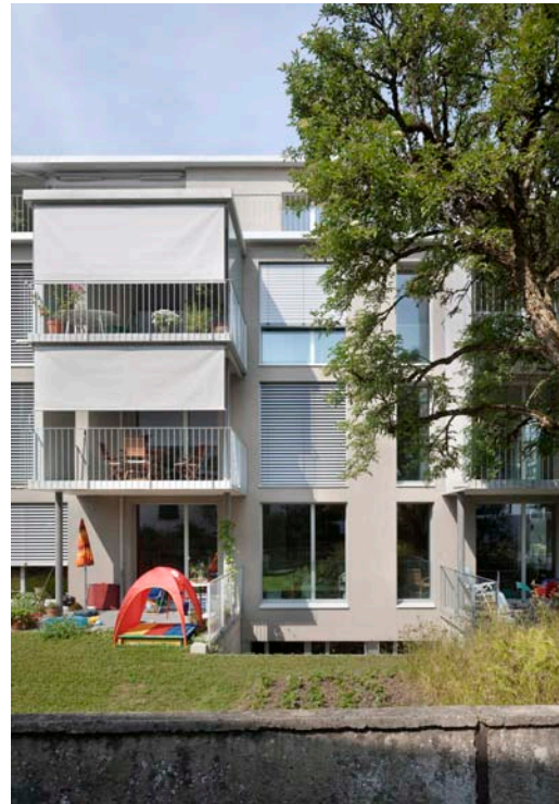
Abb. 3: Südwestansicht Haus A (noch nicht begrünt)
